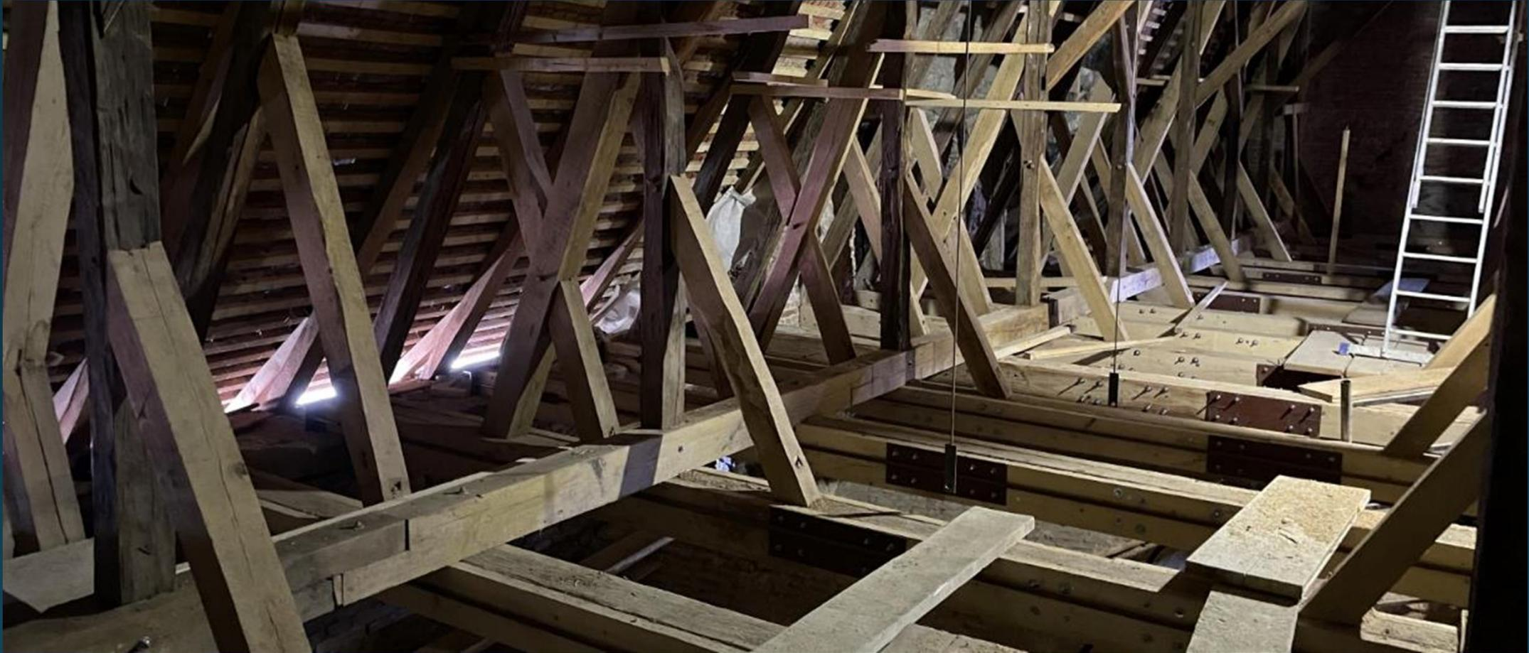
Mit Stahlbarren gespannte Deckenbalken um das Gewicht des Dachstuhl vom Gewölbe auf die Aussenmauern zu verlagern
